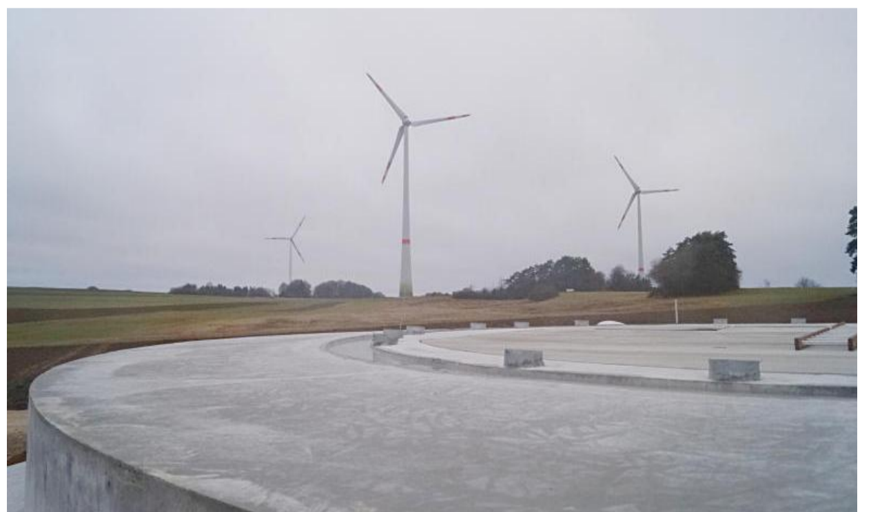
Etwa 200 Meter ist dieses Windrad-Fundament vom östlichsten Offenhausener Kraftwerk entfernt. F.: M. Keilholz
